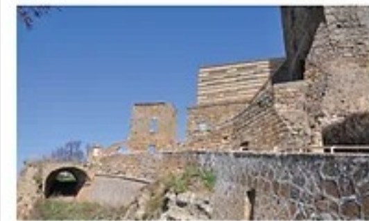
Veduta del prospetto sud da strada di accesso al borgo
